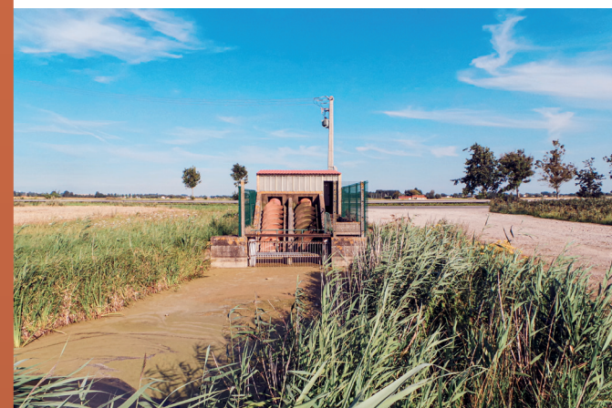
▲ La station de pompage du Moulin à Looberghe
