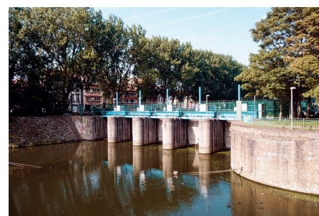
▲ L'ouvrage de jonction à Dunkerque
